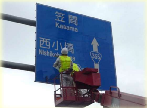
大型 標識 清掃
