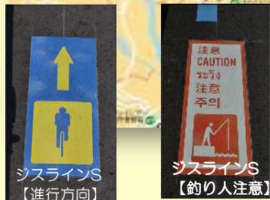
一般的に流通をしている【道路区画線】【加熱圧着型路面標示シート】では雨天時でのすべり抵抗値 経年40BPN以上と抵抗値が低い為、自転車での転倒の恐れがあります。当組合のノウハウで経年すべり抵抗値 経年60BPN以上を提案し、設置にいたしました。
