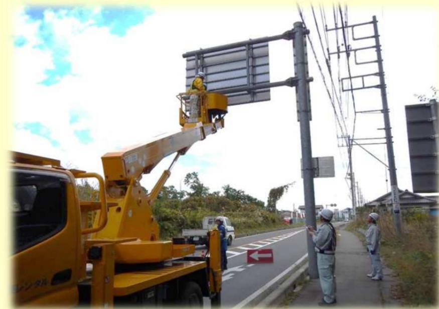
茨城県が管理する道路標識・情報提供装置について、落下や倒壊による施設の損傷等により道路を利用する方々への損害を防止すること及び早期に施設の補修を行い長寿命化を図るために総点検の作業を行いました。
