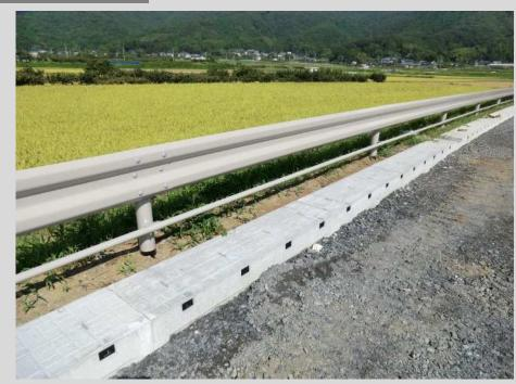
道路通行の安全をはかる為、路側ガードレールにパイプビームを設置して、 小動物侵入防止及び道路への飛び出し防止のために、設置した防護柵の施工 例です。
