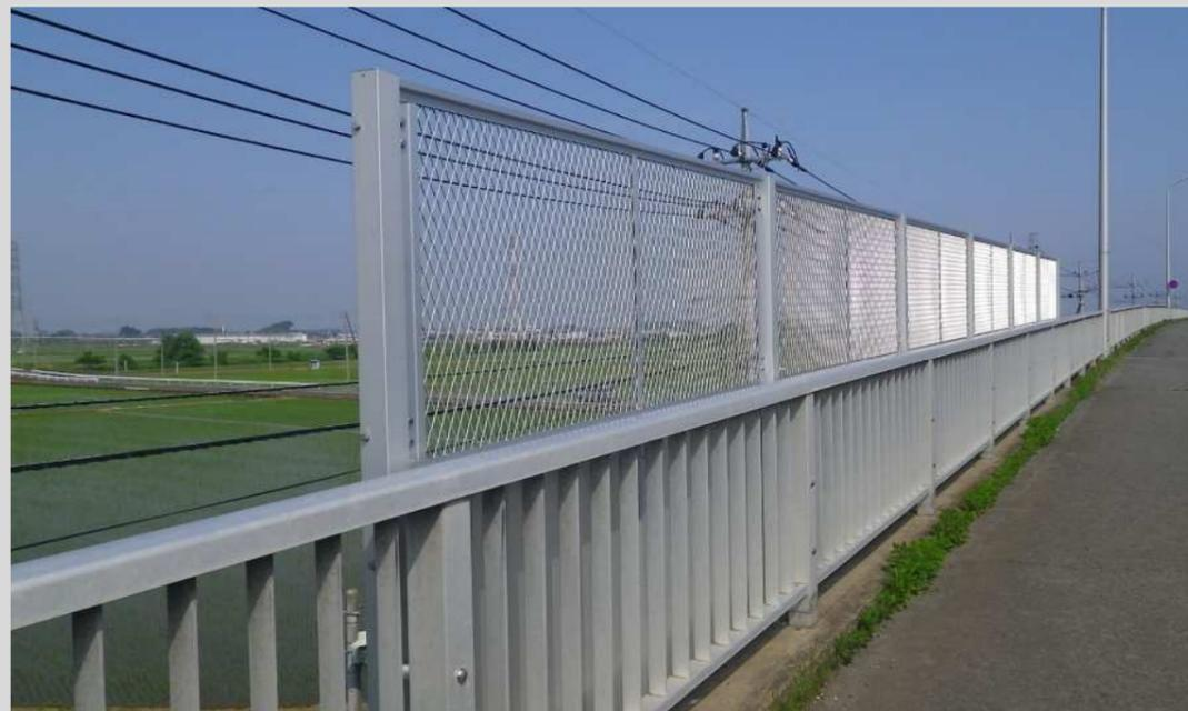
跨線橋等、橋下の安全を守る為、投物防止柵を設置の施工例です。既設の防護柵支柱を利用して、コストを抑えながら施工することができました。
